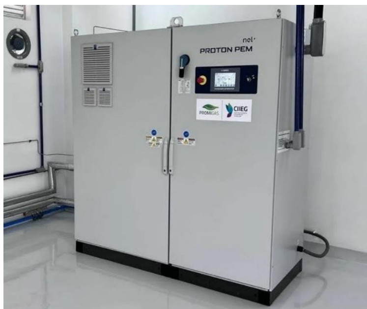
Figura N°8 Maquina Protón Pem -electrolizador
