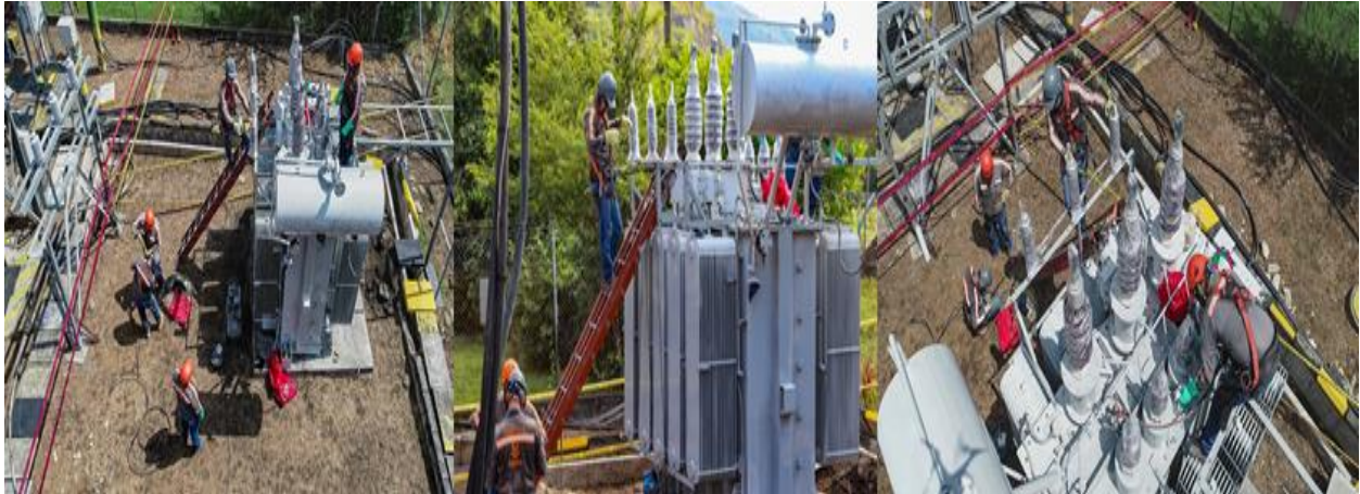
Imagen N°1. Fotografía de mantenimiento de un transformador. Área de trabajo de la subestación El Papayo de la empresa Celsia S.A. E.S.P., en el cual los colaboradores están realizando un mantenimiento de un transformador.
