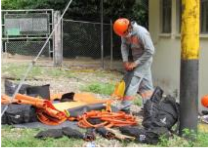
Imagen N°15. Almacenar equipos y herramientas. Este es el decimocuarto paso donde se traslada los equipos y herramientas al vehículo para llevarlo a la respectiva bodega. Fuente: Autor
