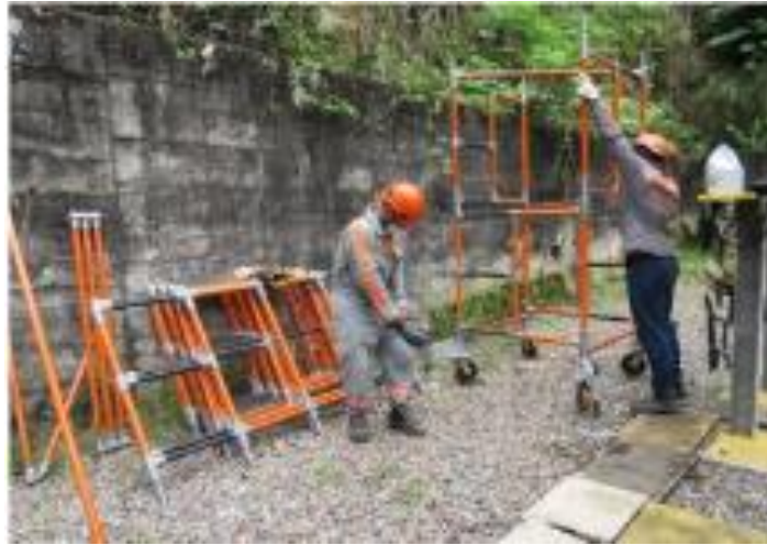
Imagen N°9. Armado y ubicación de andamio. Este es el octavo paso donde arman el andamio para realizar trabajos de altura.
