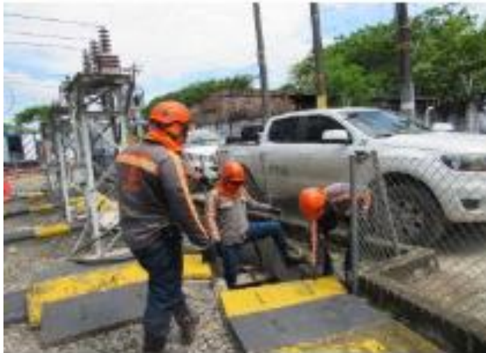
Imagen N°8. Verificación de paso de corriente. Este es el séptimo paso donde se realiza la verificación del paso de la corriente para identificar el equipo que se va a utilizar. Fuente: Autor
