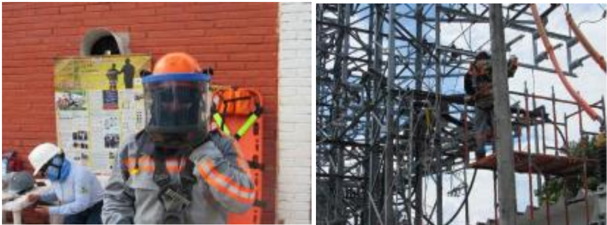
Imagen N°10. Ascenso e instalación de cubrimientos. Este es el noveno paso donde se instala las mantas aislantes para la protección del operario. Fuente: Autor
