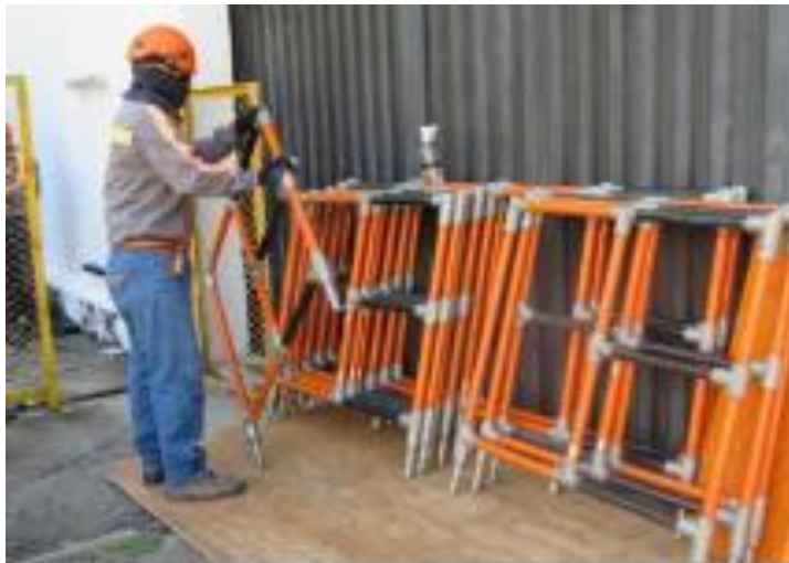
Imagen N°14. Desarme de andamios. Este es el decimotercero paso donde los técnicos se bajan y luego se desarman los andamios utilizados. Fuente: Autor
