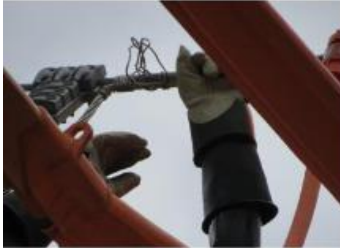
Imagen N°13. Retiro de jumper. Este es el decimosegundo paso donde se retira el jumper por parte de la persona asignada.
