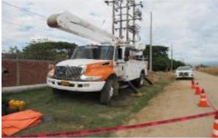
Imagen N°7. Demarcación de la zona de trabajo. Este es el sexto paso donde la persona encargada realiza la demarcación de la zona de trabajo donde no tiene acceso al personal no autorizado. Fuente: Autor
