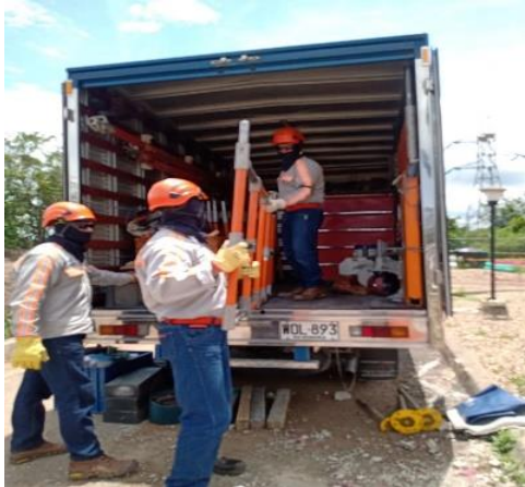
Imagen N° 2. Desplazamiento al sitio de trabajo. Este es el primer paso para la ejecución de mantenimiento en la subestación, donde los colaboradores se desplazan a la subestación El Papayo. Fuente. Autor
