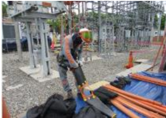
Imagen N°6. Alistamiento pruebas de equipos y herramientas. Este es el quinto paso donde el colaborador asignado realiza la prueba de alistamiento de los equipos. Fuente: Autor
