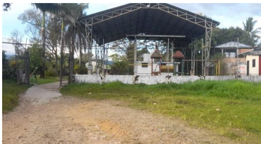
Ilustración 3 fotografía externa del CDI
