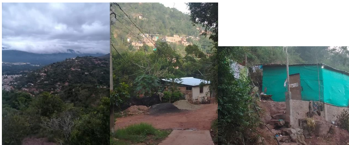
Figura 7. Viviendas de invasiones o barrios no legalizados de Piedecuesta, fuente: (elaboración propia).
